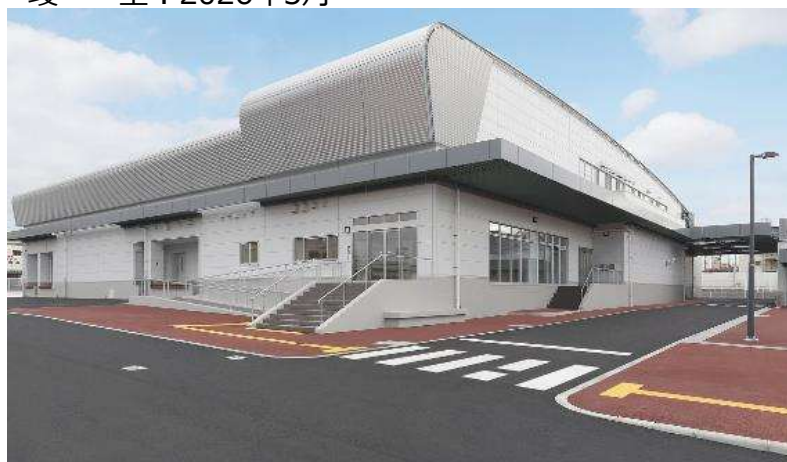
工事名称：羽曳野市立学校給食センター等複合施設 整備実施設計及び施工業務 施工場所：大阪府羽曳野市 建物用途：教育関連施設 竣工：2026年1月
