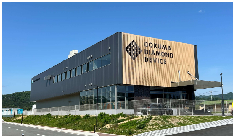
工事名称：大熊ダイヤモンドデバイス第1工場新築工事 施工場所：福島県双葉郡 建物用途：工場・生産施設 竣工：2026年3月
