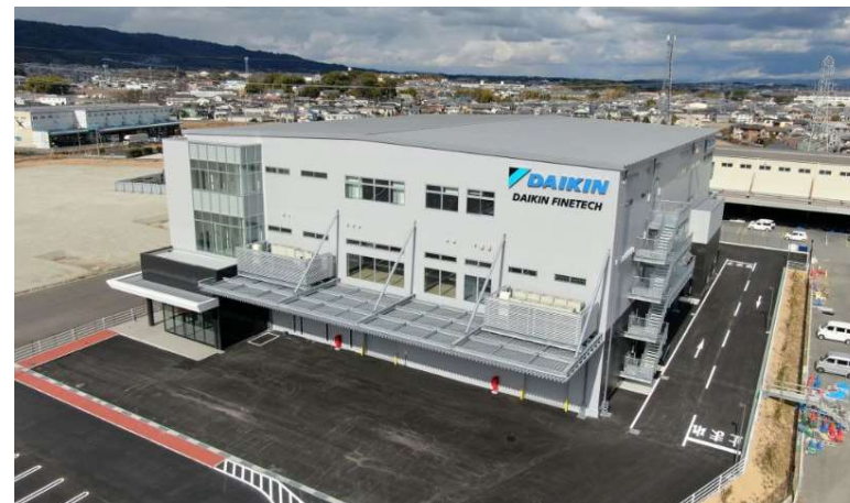
工事名称：ダイキンファインテック新工場建設プロジェクト 施工場所：奈良県大和郡山市 建物用途：工場・生産施設 竣工：2025年7月
