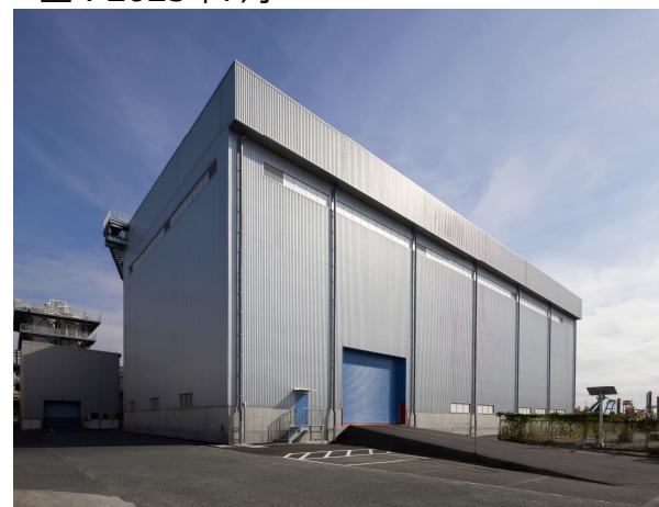
工事名称：ブリヂストン下関工場第五工場新築工事 施工場所：山口県下関市 建物用途：工場 竣工：2025年10月
