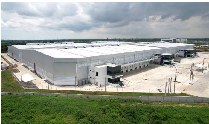
工事名称：ESRAS-RDB02（ESRAS第2期工事） （バクザン）工場増築工事 施工場所：タイ 建物用途：工場 竣工：2026年1月
