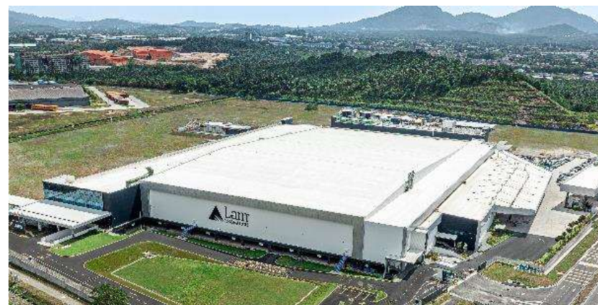
工事名称：ラムリサーチ クリーム工場新築工事 施工場所：マレーシア 建物用途：工場・生産 竣工：2026年3月
