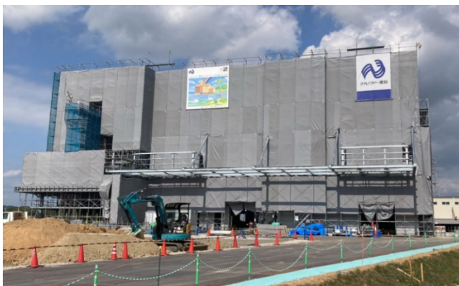
ダイキンファインテック新工場建設プロジェクトに掲出
