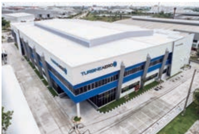
タービンエアロリペア工場（タイ） 発注者：タービンエアロリペアCO.,LTD. 設計者：タイナカノCO.,LTD. 構造：鉄筋コンクリート造 規模：地上2階 延床面積：8,115㎡
