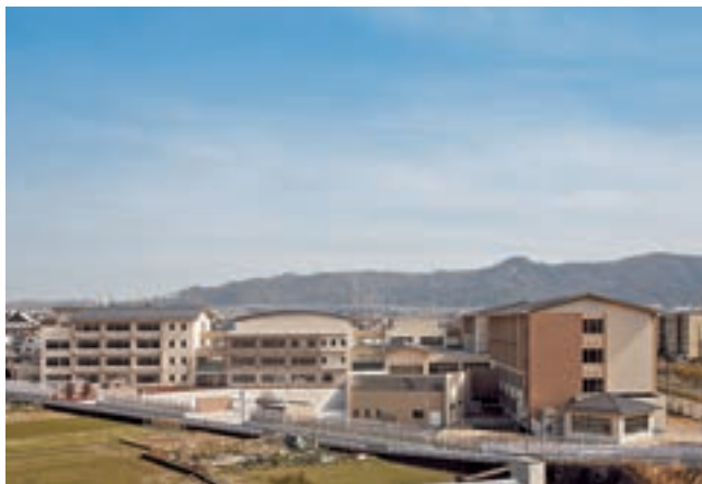
大阪府立北河内地域支援学校（仮称）及び 大阪府立北河内地域高等支援学校（仮称）（第2工区）
