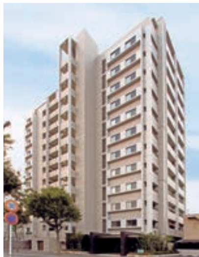
(仮称) オーヴィジョン寿町 構 造：鉄筋コンクリート造 規 模：1棟 地上13階 延床面積：4,642.51㎡
