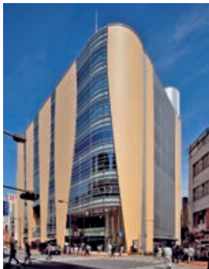
(仮称) 栄真池袋東口プロジェクト 構 造：鉄骨造 規 模：地下4階 地上8階 塔屋2階 延床面積：16,961.86㎡
