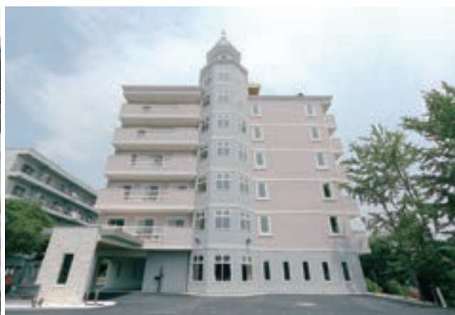
社会福祉法人さわらび会 介護付き及び自立型有料老人ホーム福祉村 (仮称) 構 造：鉄骨造 規 模：地上8階 塔屋1階 延床面積：3,991.69㎡
