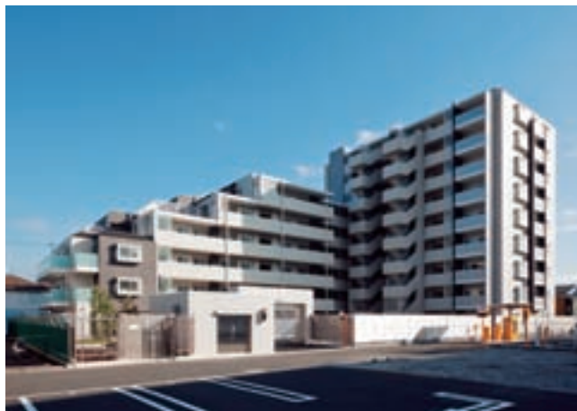
(仮称) リーフアレジデンス中央林間マンション計画新築 (神奈川県大和市) 構造: 鉄筋コンクリート造 規模: 地上9階 延床面積: 5,304.63㎡
