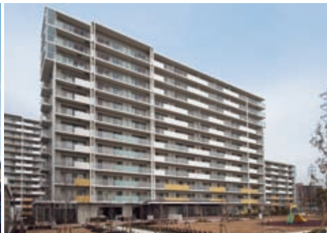
コンフォール松原第1期(後工区)第8住宅建設 (埼玉県草加市) 構造: 鉄筋コンクリート造 規模: 2棟 地上8階・地上12階 延床面積: 10,164.08㎡
