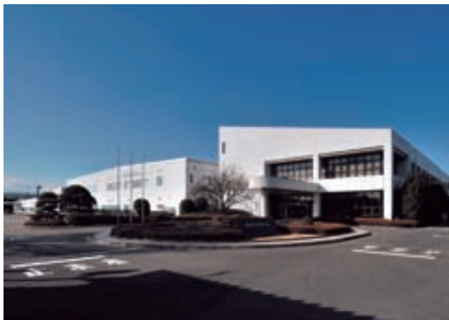
横浜電子機器泰野工場新築（神奈川県秦野市）
