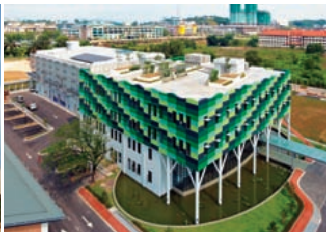
NTTマレーシアデータセンター及び事務所新築 (マレーシア) 構造: 鉄筋コンクリート造 規模: 地上4階 延床面積: 9,280㎡
