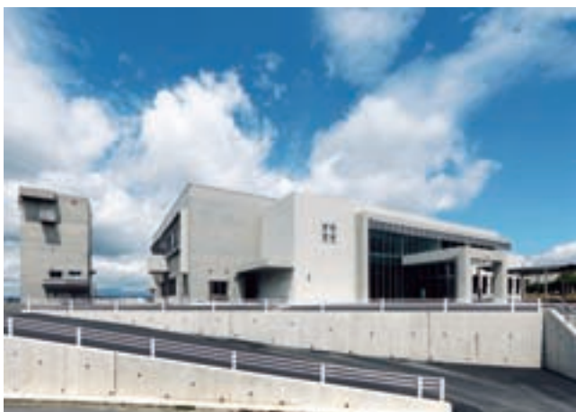
（仮称）新消防庁舎・名張市防災拠点施設新築工事（三重県名張市） 構造：RC造 規模：1棟 地上2階 延床面積：4,161㎡
