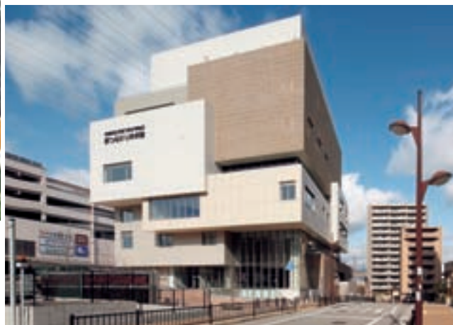
(仮称) 青少年拠点施設及び子育て支援及び山田駅前図書館建設 (大阪府吹田市) 構造：SRC造 規模：1棟 地下2階／地上7階 延床面積：7,585㎡
