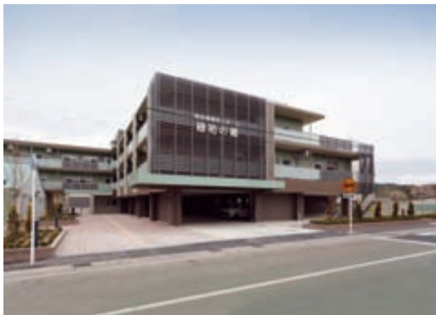
社会福祉法人市原うぐいす会特別養護老人ホーム（千葉県市原市） 構造：RC造 規模：1棟 地上3階／塔屋1階 延床面積：5,507㎡
