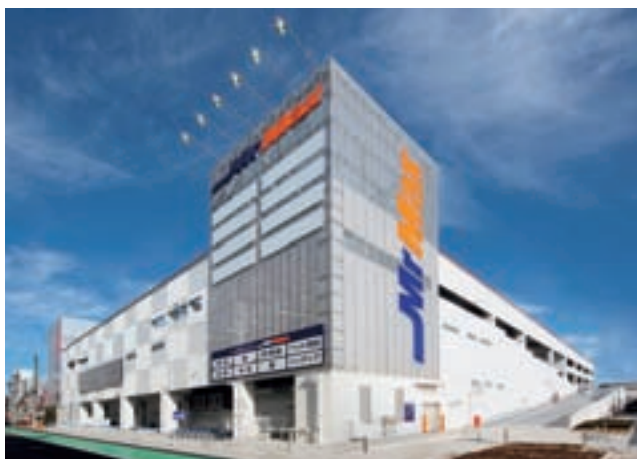
（仮称）越谷ビル新築工事（埼玉県越谷市） 構造：S造 規模：1棟 地下1階／地上3階／塔屋1階 延床面積：22,878㎡
