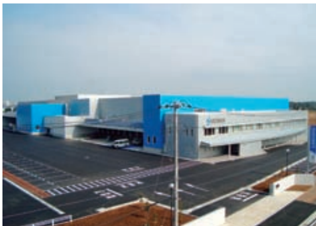
スズケン 千葉物流センター（千葉県印西市） 構造：S造 規模：2棟 地上2階 延床面積：11,226㎡
