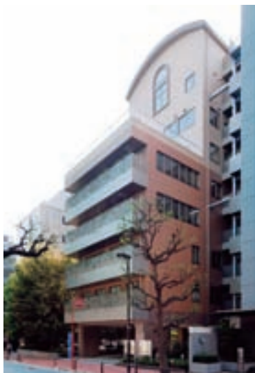
障害者福祉センター・御茶の水教会 (東京都千代田区) 構造: S造 規模: 1棟 地上8階 延床面積: 2,871㎡
