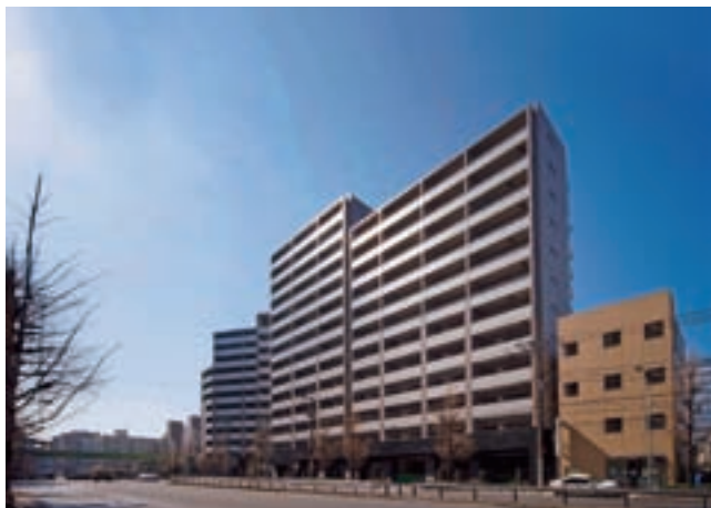
神谷1丁目マンション北棟、南棟 (東京都北区) 構造: RC造 規模: 地下1階/地上14階 (北棟)、地上12階 (南棟) 延床面積: 11,054㎡
