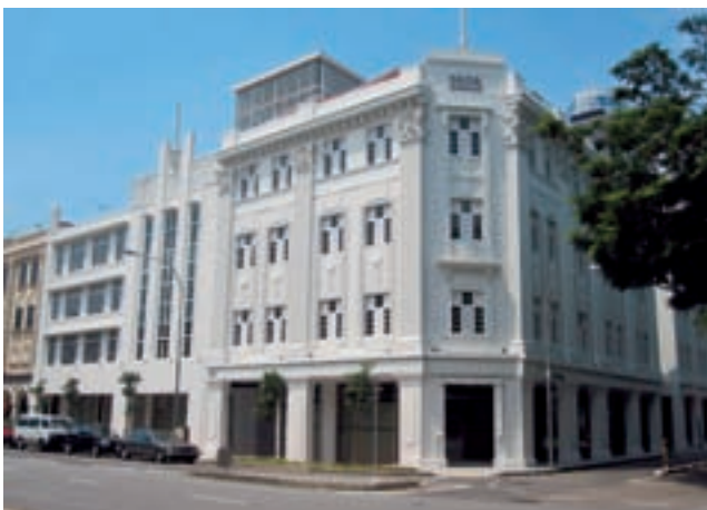
アルメニアンストリート歴史的建造物保存改修（シンガポール） 構造：RC造 規模：地上6階 延床面積：6,123㎡
