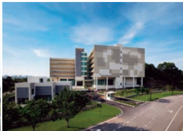
CSFデータセンター（マレーシア）
